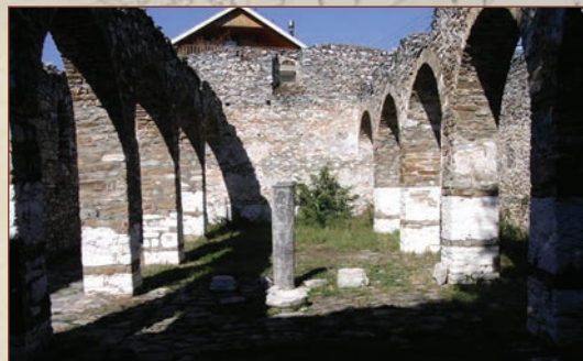
Έσωτερικό του ιερού ναού πρό της αποκαταστάσεώς του
